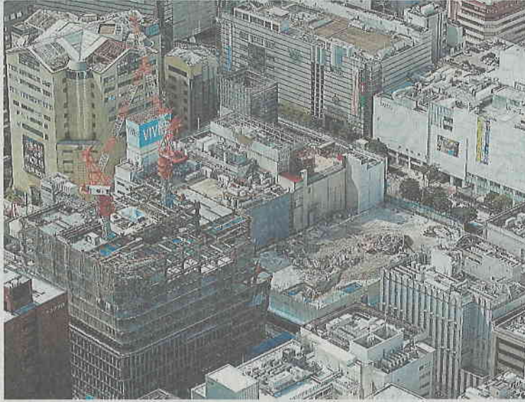
再開発で解体される天神地区の福岡ビル(中央)＝28日午前、福岡市中央区、本社ヘリから、堀英治撮影
