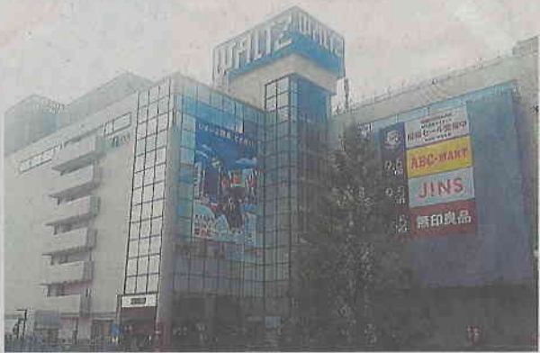
ショッピングセンターに改装される西武所沢店。9月、埼玉県所沢市
